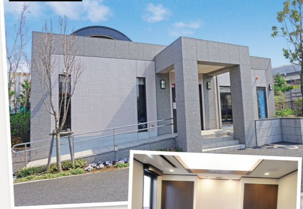
RC造・管理棟外観
